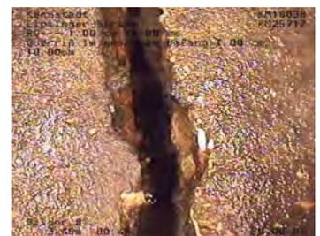
**Mit dem TbL-Verfahren werden schadhafte Abwasserleitungen (DN 100 - 400 mm) repariert und somit dauerhaft abgedichtet und saniert.**
